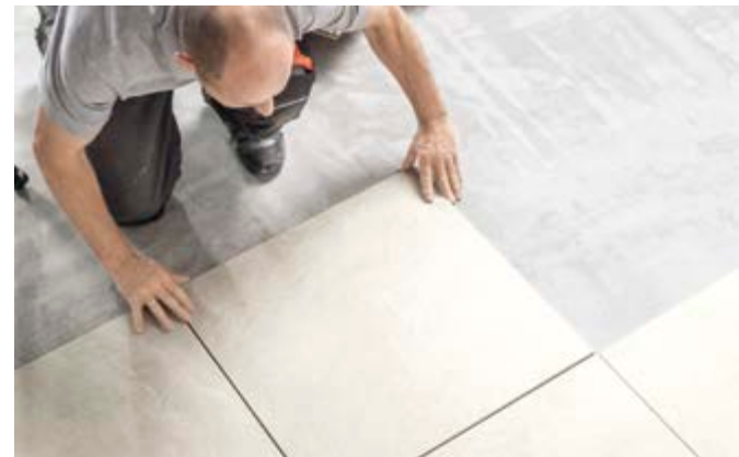
3 Fugenraster festlegen und Korkkanten press aneinander legen.
