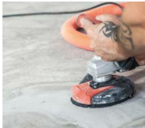
2 Boden ggf. nachbearbeiten, um die Anforderungen an die Ebenheit zu gewährleisten.
